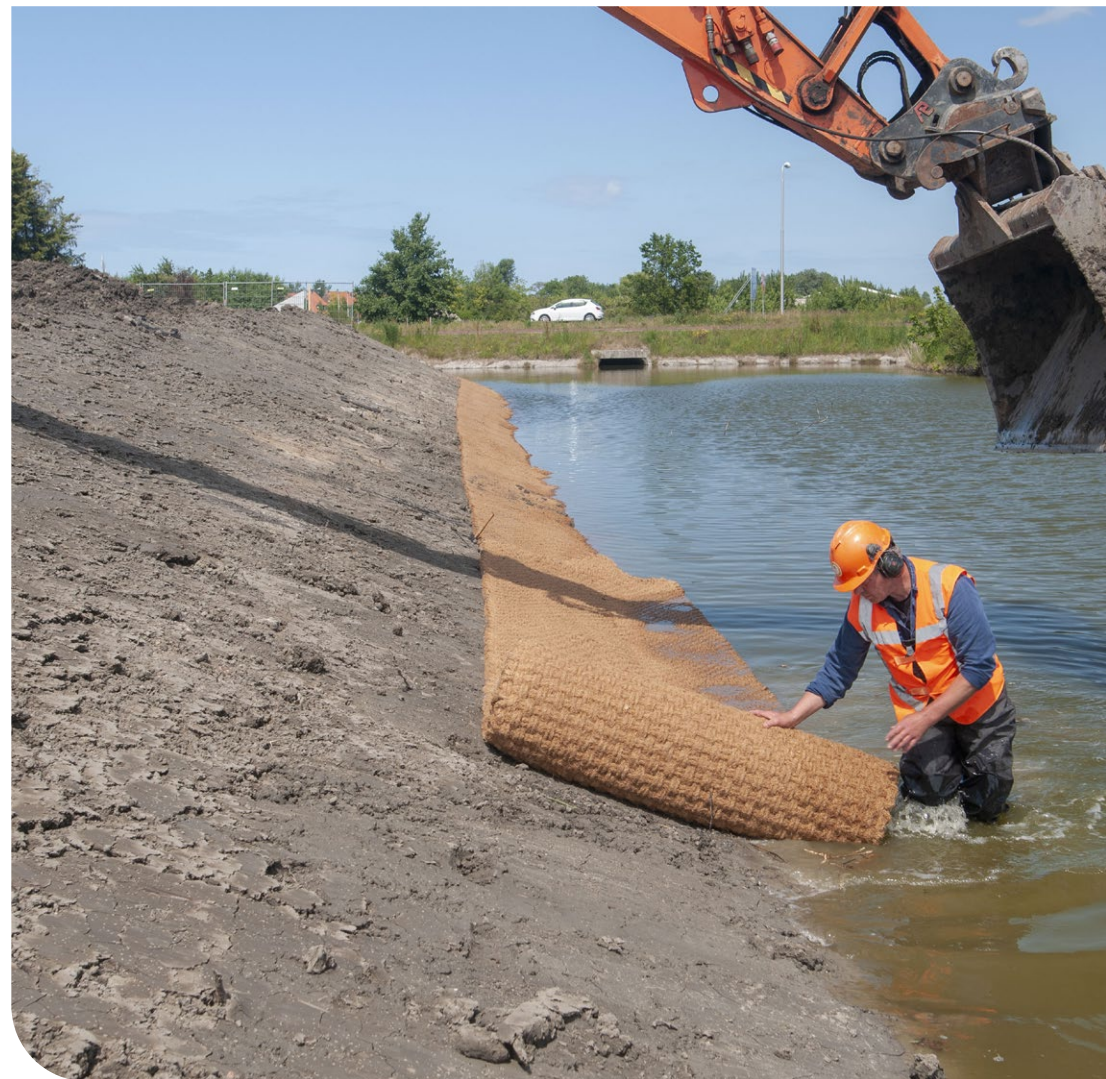
Figuur 24 - Biobased oeverversterking in plaats van kunststof.
